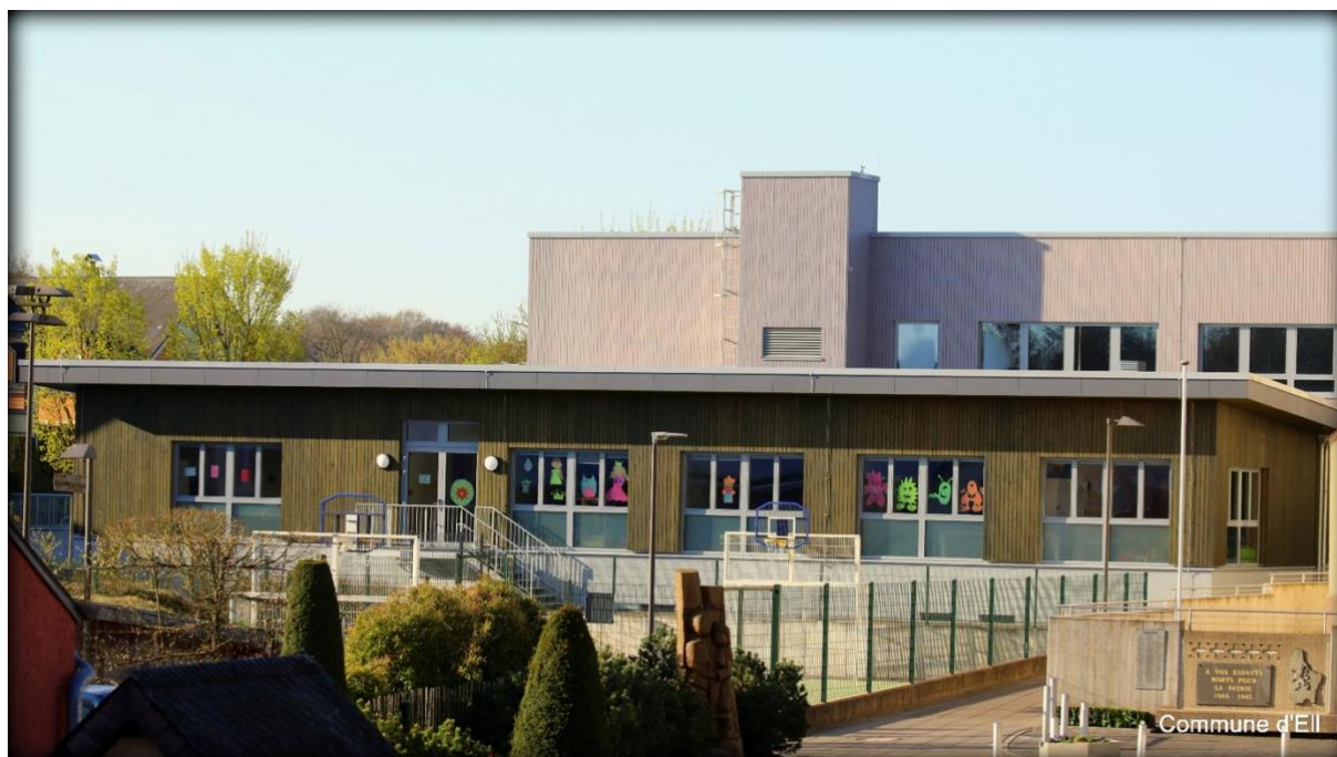
La nouvelle Maison Relais au printemps 2018.
