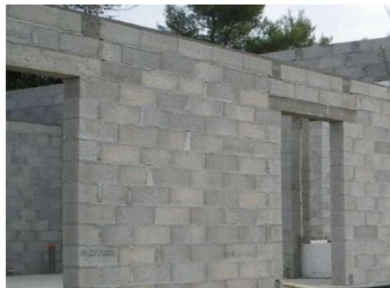
Un chaînage périphérique en béton armé est prévu pour la stabilisation des murs et pignons de façades ainsi que pour la reprise et répartition des charges de la toiture.
