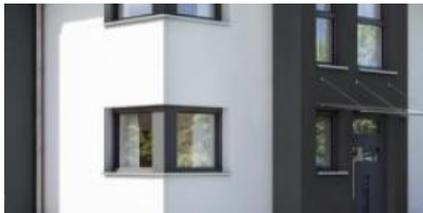
Les murs extérieurs sont revêtus d'une façade isolante en polystyrène expansé épaisseur définie suivant le calcul énergétique) avec un enduit d'armature et un enduit final limousin à base de silicate resp. de silicone (teintes claires au choix du Maître de l'Ouvrage dans la palette proposée par le Promoteur).
