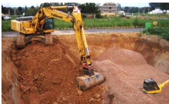
Déblaiement des terres arables sur toute la surface du bâtiment à construire. Terrassement en pleine masse jusqu'au niveau inférieur, ainsi que terrassement des rigoles de fondations resp. du radier et de canalisations suivant les indications des plans d'architectes et de l'ingénieur-conseil.
